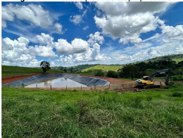
Figura 11: Vista do piscinão da propriedade.
